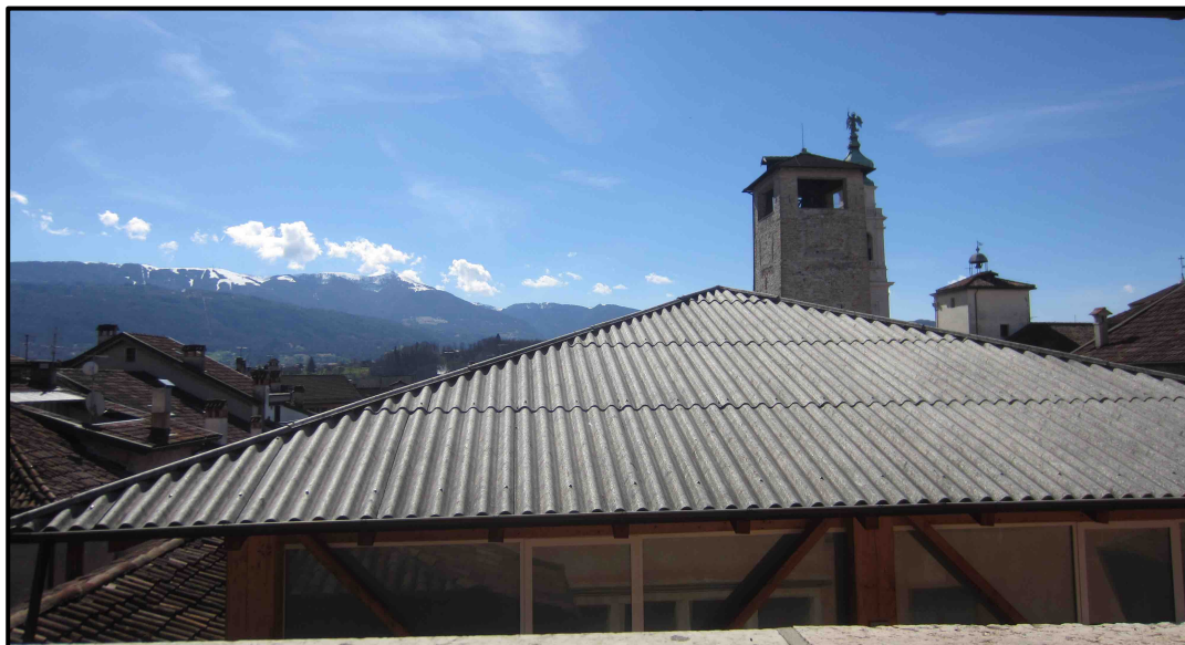
Foto 6 - Manto di copertura in lamiera ondulata
