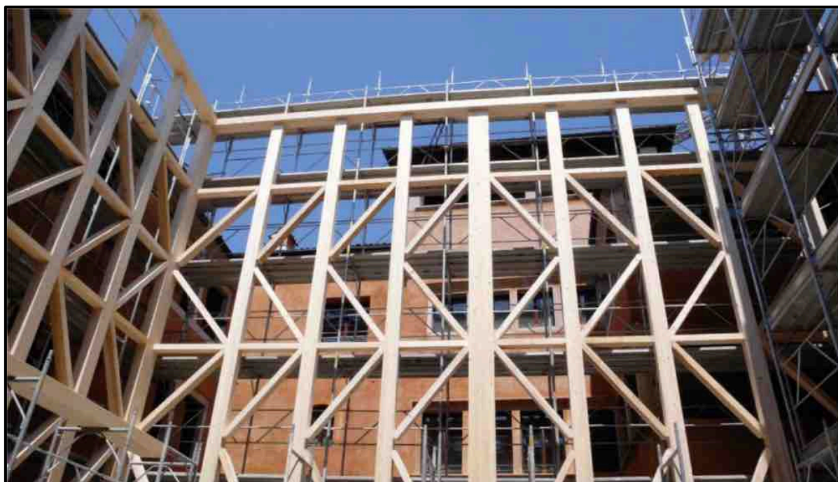
Foto 2 – Struttura portante in legno
