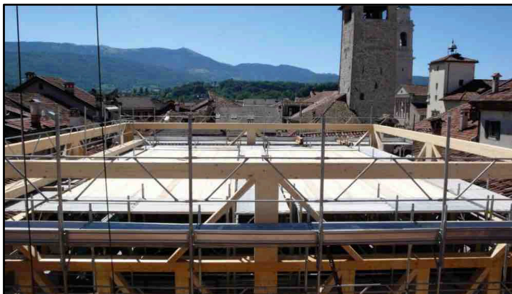
Foto 3 – Struttura portante in legno e controsoffitto in tavolato ligneo
